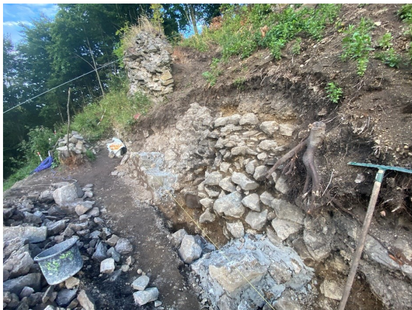
Nově založená pata zdiva do původních kapes
