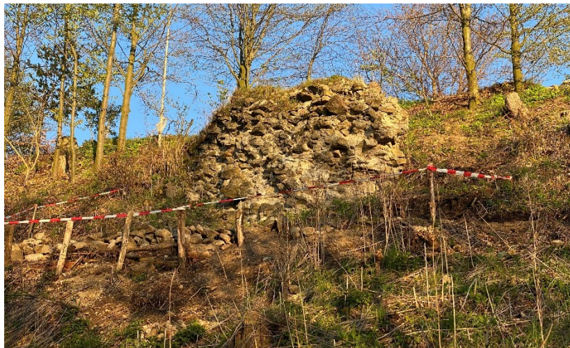
Záchrana střepu parkánové hradby
